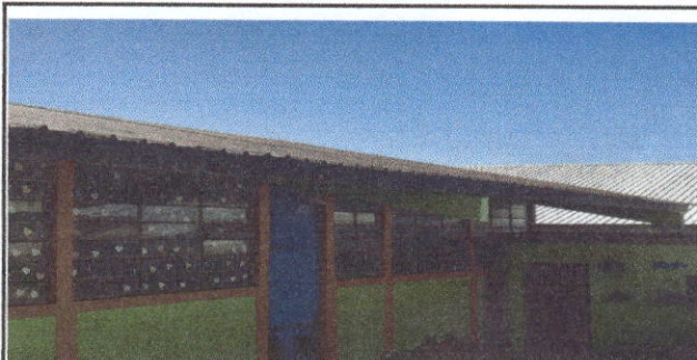
Foto 6: se sustituirán las laminas
