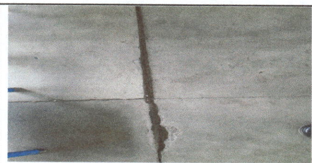
Foto 5: Se levantará el piso de concreto y luego colocar cerámica
