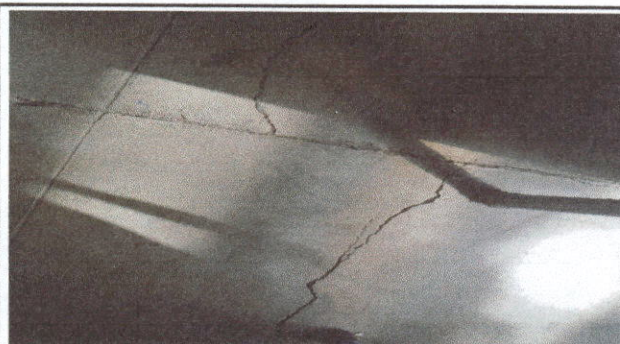
Foto 4: se colocará piso de cerámica en las aulas
